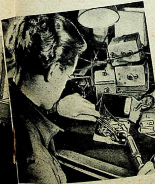
Montage von Mikrofonverstärkern für Rufanlagen zum Selbstbau Links: Aus verschiedenem Altmaterial entstehen neue Radiogehäuse Rechts: Beratung des Kunden ist eine der wichtigsten und vornehmsten Aufgaben des Radiohandels
